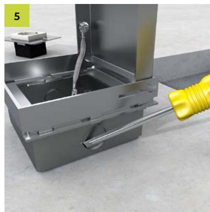
Perforation an den Seitenwänden der Bodensteckdose entfernen und Leerrohr einführen.
