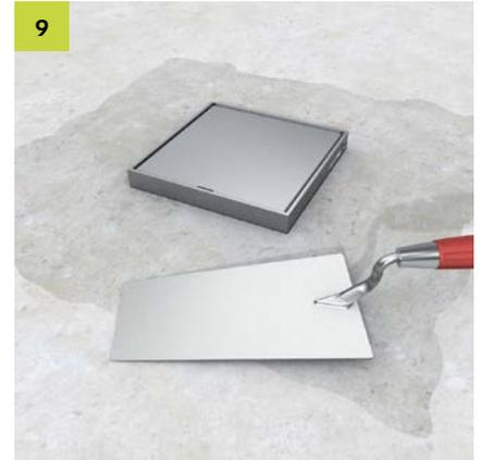
Vor Einbringen des Mörtels ist die Position der Bodensteckdose zu prüfen. Den Mörtel ohne Lufteinschlüsse einbringen, bei Bedarf den Spalt zwischen Rahmen und Deckel abkleben.
