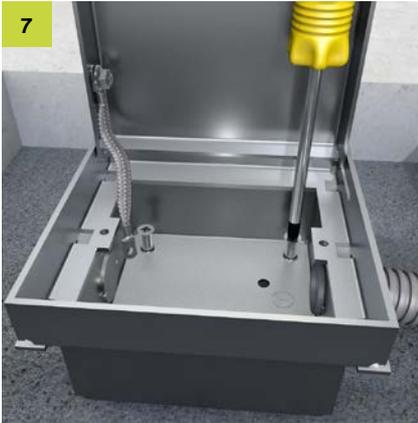
Die waagerechte Ausrichtung und Höhenverstellung der Bodensteckdose erfolgt über die vier Stellschrauben. Bei Bedarf kann die Bodensteckdose auf dem Unterboden fixiert werden.
