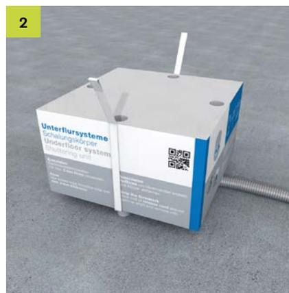
Leerrohre am ausgerichteten Schalungskörper fixieren. Vor Einbringen des Estrichs den Schalungskörper auf dem Rohboden befestigen und so gegen Aufschwimmen sichern.
